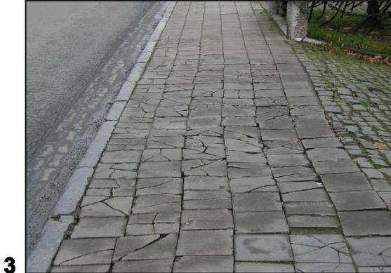
3 Revêtement déterioré (entrée de camions) : à remplacer par de l'asphalte
