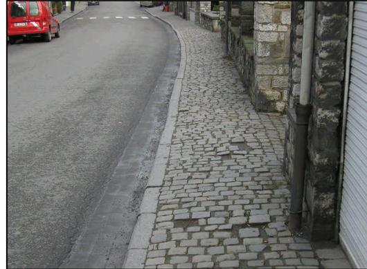
4 Vieux pavés de grès à remplacer par un revêtement plus confortable
