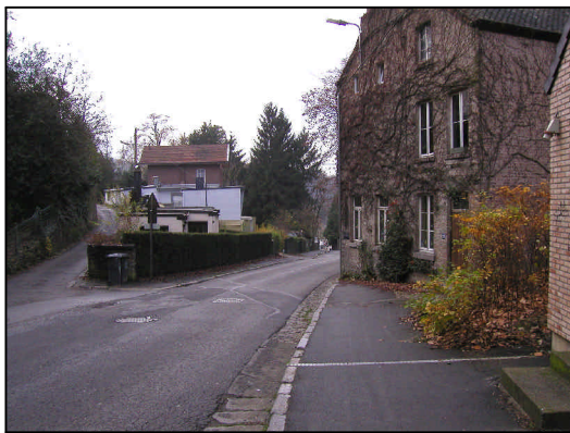
Trottoir interrompu : avancée à réaliser sur la chaussée
