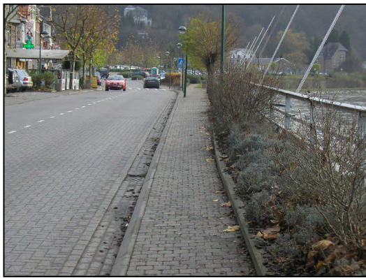
Dans le prolongement du RAVeL, un trottoir étriqué à élargir
