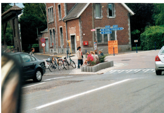
Traversée du village de Ohey par les nationales N 921 et N 698. Les usagers doux ont de l'espace, le plateau ralentit effectivement le trafic.
