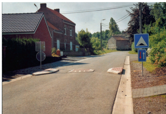
Un coussin berlinois: ce dispositif surélevé permet de ralentir les voitures sans contraindre les bus, les vélo, les cyclomoteurs et les camions. Il peut notamment servir d'effet de portes (entrée de Couthuin).
