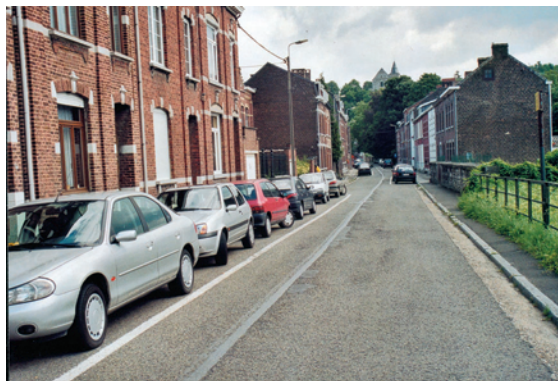
Le stationnement alterné sur la chaussée permet de modérer le trafic. Il rompt la perspective (dévoiement) et réduit l'espace de circulation motorisé.
