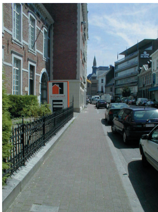
Un bon trottoir: large, avec un revêtement régulier, également adapté aux PMR © Plain-Pied
